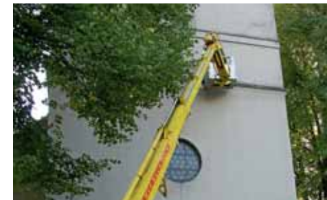
Die Arbeiten beginnen.
