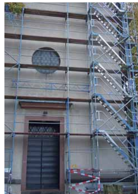
Der eingerüstete Turm von St. Gereon
