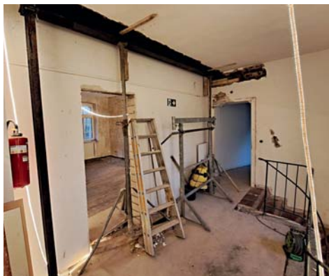
Stahlträger für die neue Treppe zum Dachgeschoss
