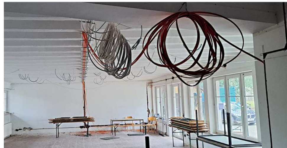
Erneuerung der Elektroleitungen
