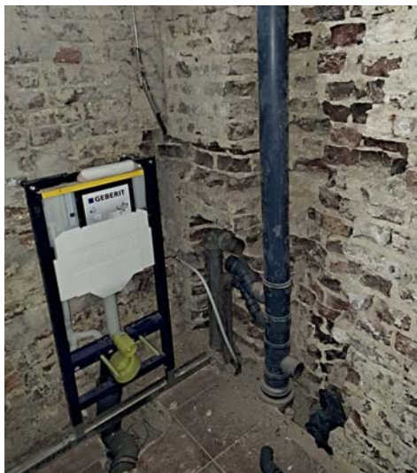
Erneuerung der Wasserleitungen
